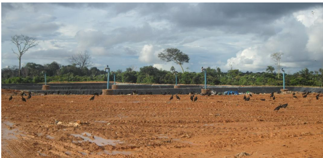
Figura 05: Aterro Sanitário do Canteiro de Obras
