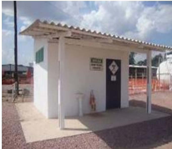
Figura 03: Depósito de Resíduos de Saúde (Abrigo Externo/Ambulatório)
